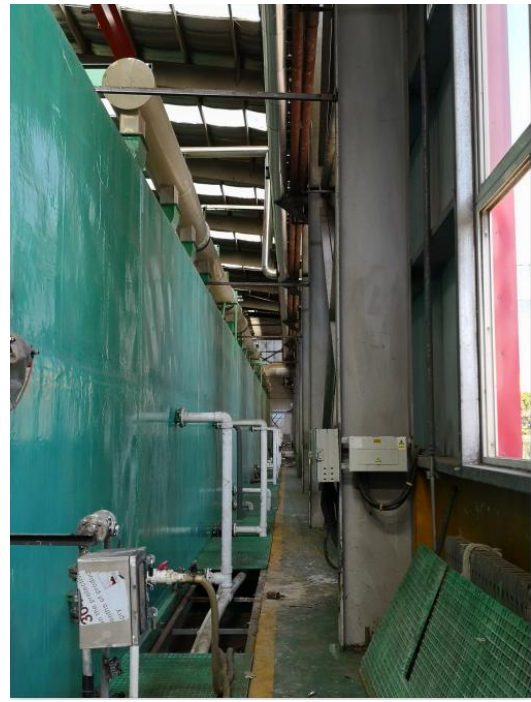
酸洗线集气管线
